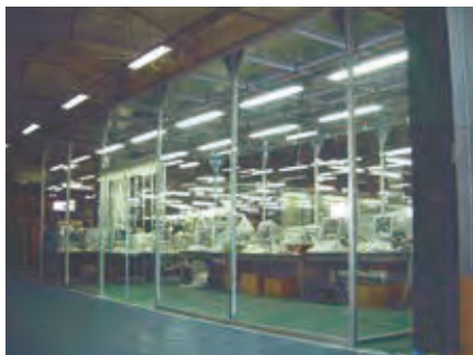
事務所ビニールブース
