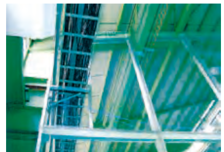
障害物間仕切り工事
