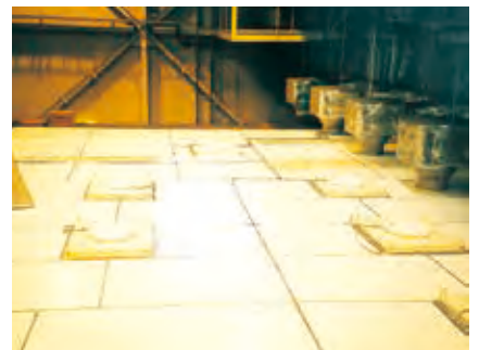
クリーンブース天井面
